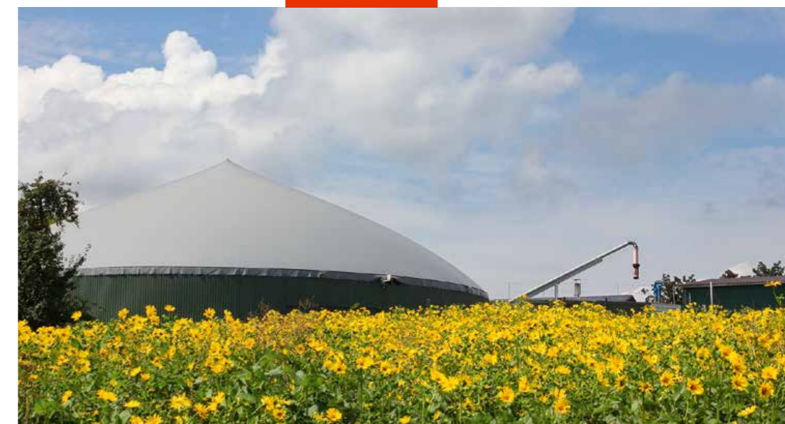
Eine moderne Biogasanlage versorgt fast alle Haushalte in Hesselbronn mit Wärme und Strom.
