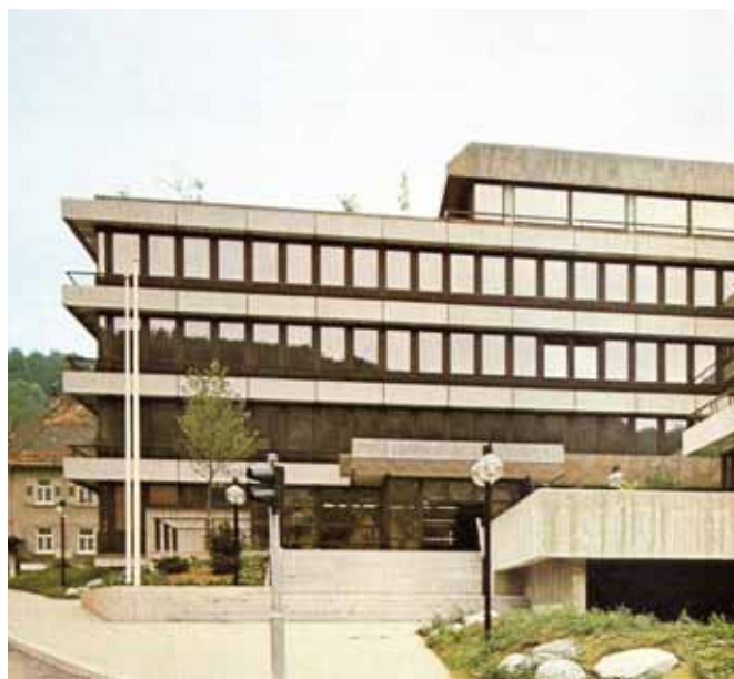
Neubau des Landratsamts 1977.
