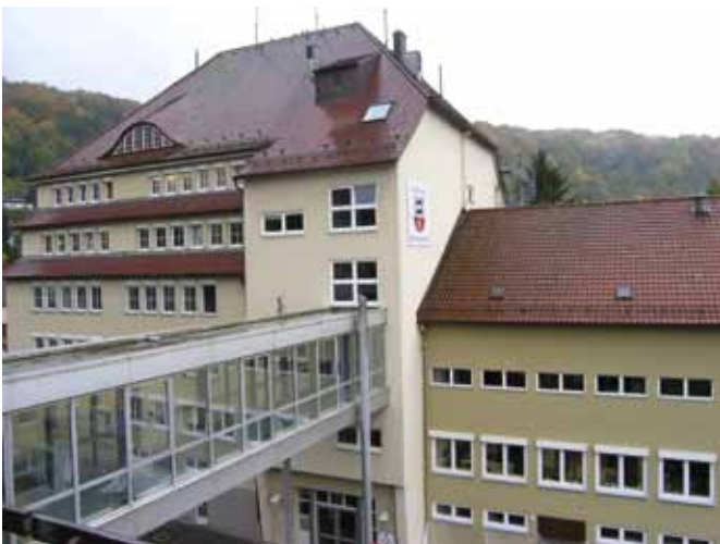
2001 erwirbt der Hohenlohekreis das ehemalige HOBAG-Gebäude und baut es 2004 vollständig zum Verwaltungsgebäude um. Der Steg verbindet die Gebäudeteile A und B.
