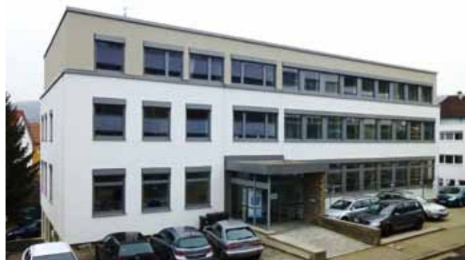
Vermessungsamt in der Stettenstraße 31 in Künzelsau.
