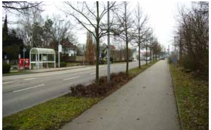
Die Beseitigung des Bahnübergangs Kottmannstraße in Öhringen war von 1998 bis 2000 ein wichtiges Kreisstraßenprojekt.
