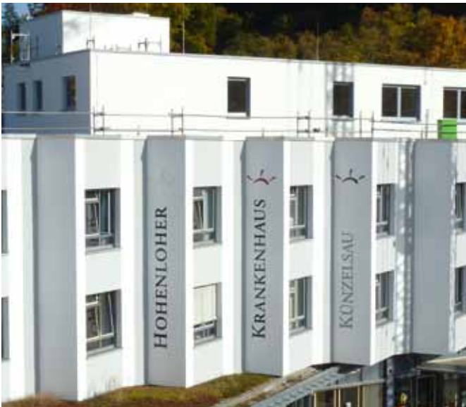
Im Jahr 2012 wird für die neue Psychiatrische Tagesklinik auf das Künzelsauer Krankenhausgebäude ein weiteres Stockwerk aufgesetzt.
