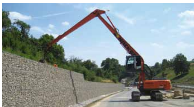
Ausbau der B 19.
