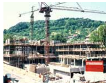
Das neue Landratsamt entsteht an der Künzelsauer Alleekreuzung.
