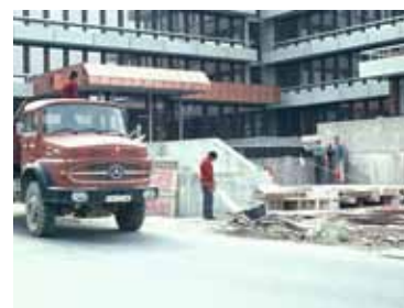
Das Gebäude steht, die Außenarbeiten sind jedoch noch nicht abgeschlossen.
