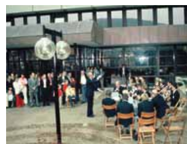
Im September 1977 präsentiert sich das neue Verwaltungsgebäude erstmals den Bürgern.
