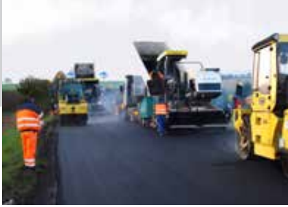
Fahrbahndeckenarbeiten auf der B 19
