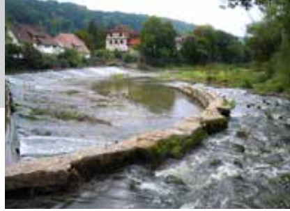
Verbesserung der Fischwanderung durch einen Fischaufstieg in Forchtenberg
