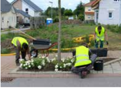
Anlage eines Blumenbeets durch die MH Mobil Hohenlohe GmbH
