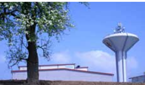
NOW-Wasserwerk in Niedernhall.
