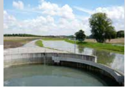
Regenrückhaltebecken im Gewerbepark Hohenlohe
