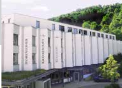
Krankenhaus in Künzelsau
