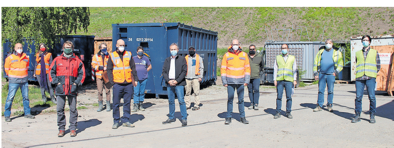
Baustelleneröffnung zum Deponiebau mit allen Projektbeteiligten.
